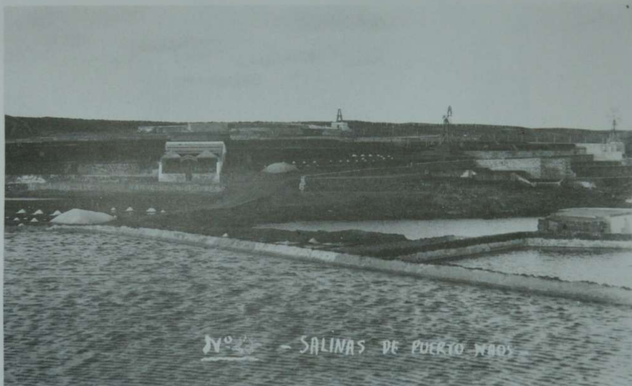
Salinas del Muelle de Palo en Portonao.
