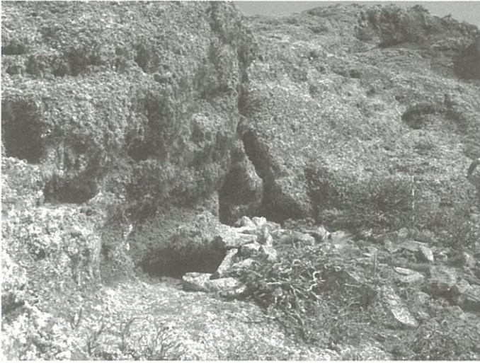
Solapón acondicionado de Los Picachos.
