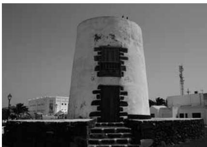
queda de los 12 molinos que trituraban el grano proveniente de los campos. La construcción es una sencilla estructura de panta circular de dos pisos y techumbre cónica. En cuyo interior está la maquinaria, las aspas y dos grandes piedras muy duras y redondas, con un orificio central.
