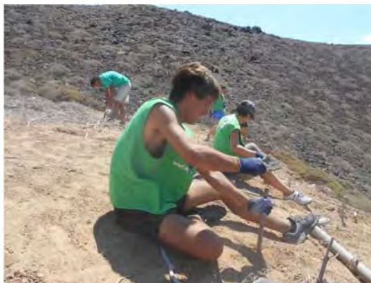
Ilustración 120.- Construcción de fajas y bancales WWF/España
