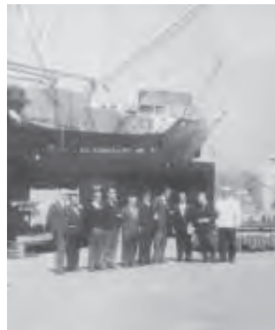
Llegada a Lanzarote de la maquinaria para la desalinizadora de Arrecife.
