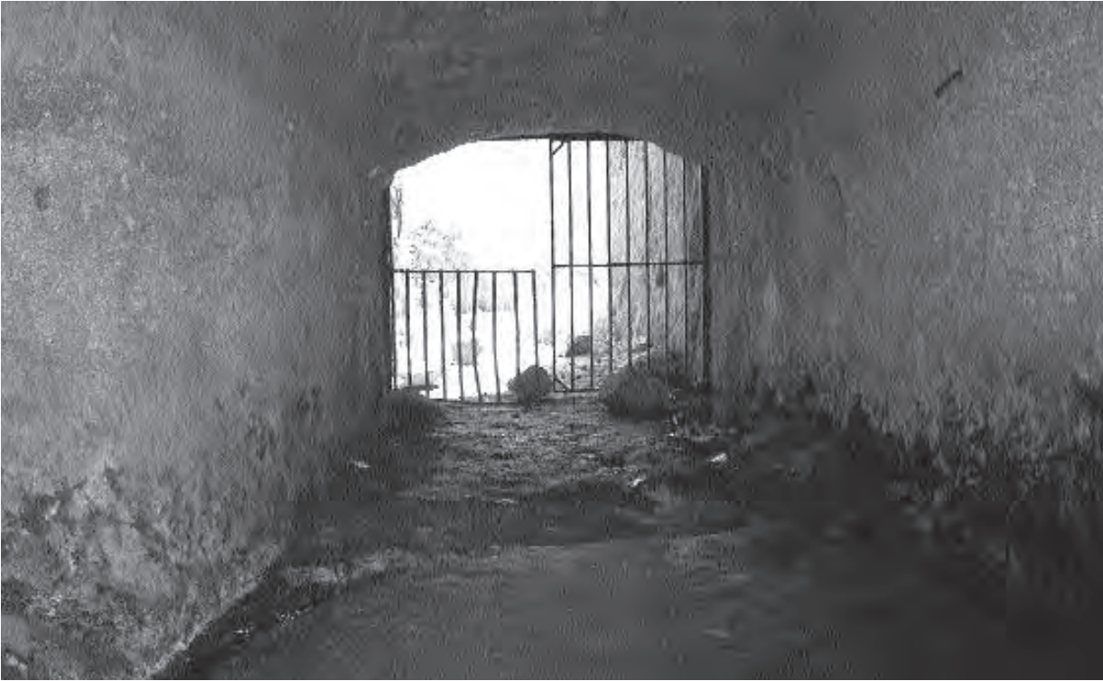
Túnel de entrada a Chafariz.
