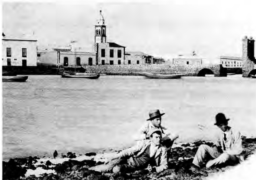
El Puente de las Bolas era el único que existía en el Puerto del Arrecife. Fue utilizado para paseo y recreo
