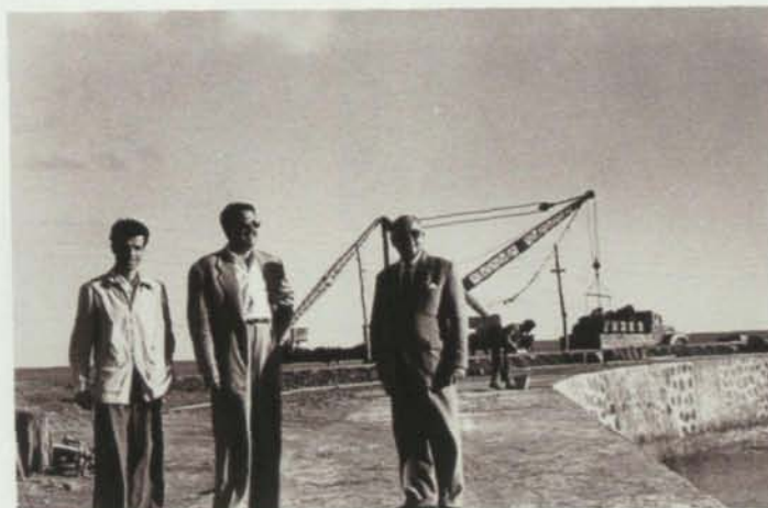
Visita a las obras.
