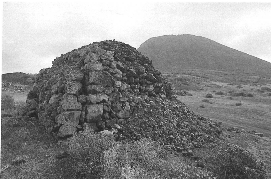
Construcción agrícola- pastoril, adosada a un dique volcánico, que conforma una pared excepcional
