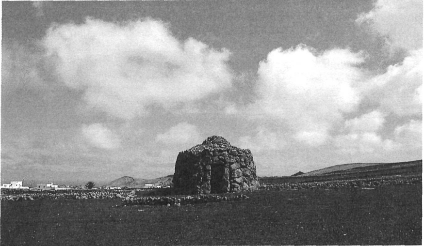
Construcción exenta de gran envergadura en Tinajo
