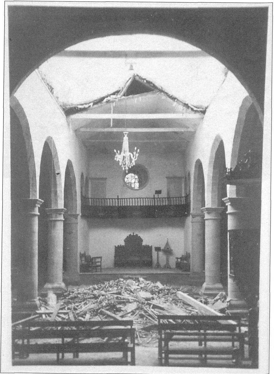
Foto 3. Vista del interior del recinto, en los momentos previos a su demolición.
